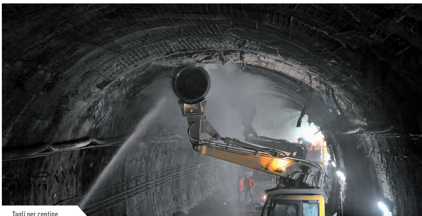
Lavori in immersione
